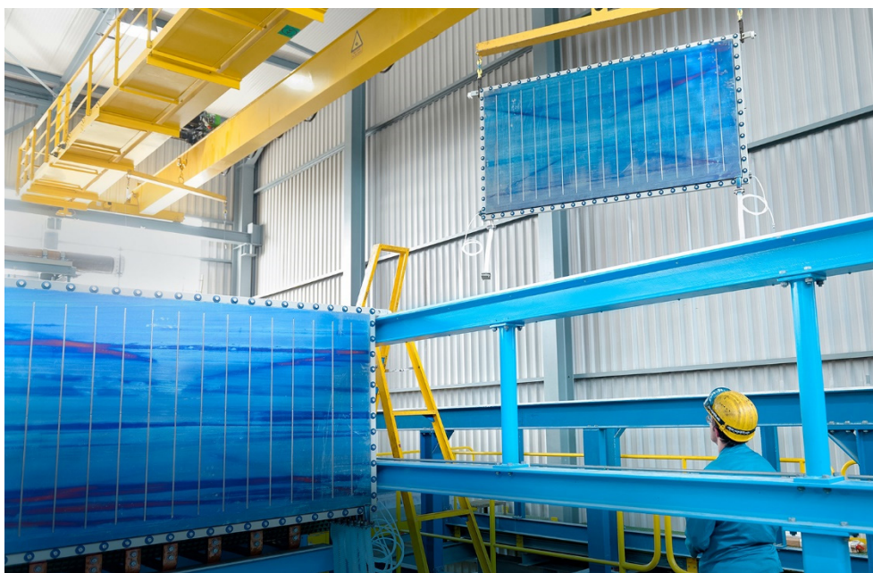
Montage von Elektrolysezellen
